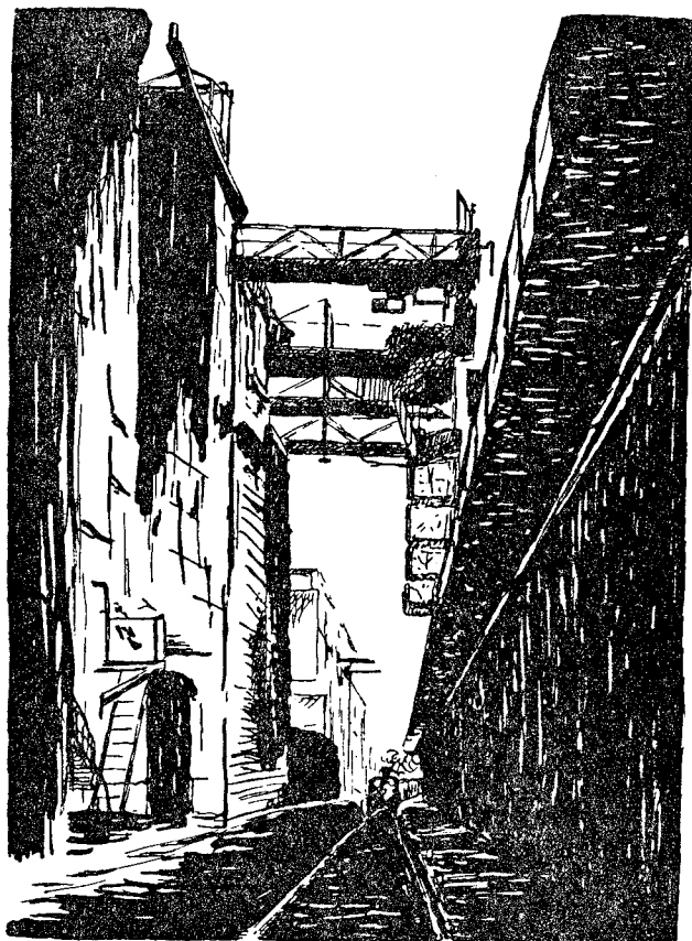
Betonové komory pro vysokotlakové pece na zkapalňování uhlí
